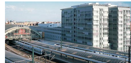
Железнодорожный вокзал, 1 250 кВт
