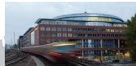
Торговый центр, 1 020 кВт
