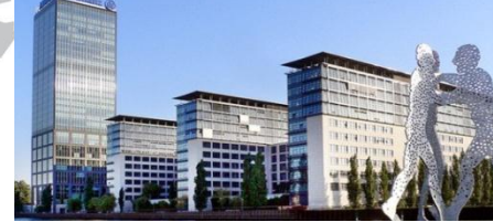
Комплекс административных зданий, 4 220 кВт
